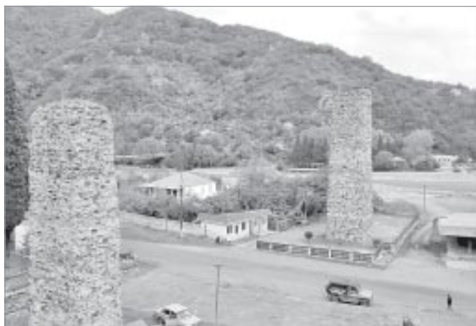
Опоры недостроенного железнодорожного моста через Бзыбь
