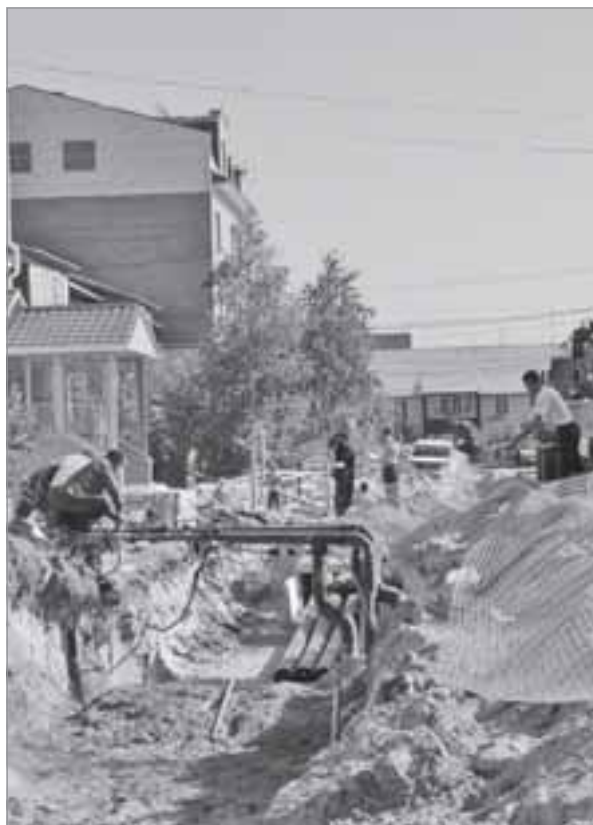
Работа по замене сетей ТВС в городе не останавливается ни на один день
