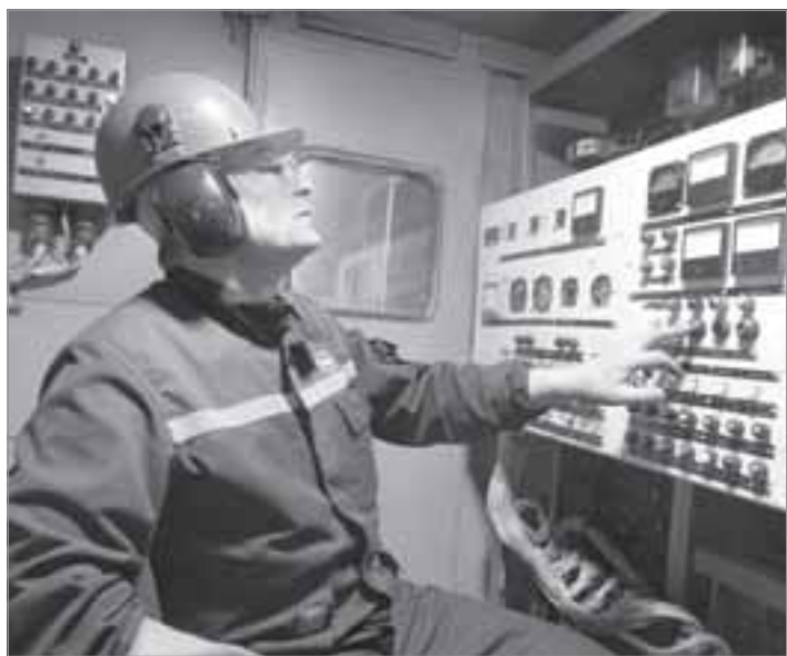
Электромонтер Иван Хавкунов производит синхронизацию и включение ПАЗС-2500
