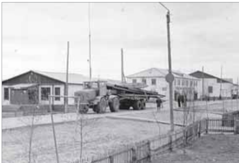
Посёлок преобразился - первая «бетонка», ул.Геологов, 1976г.
